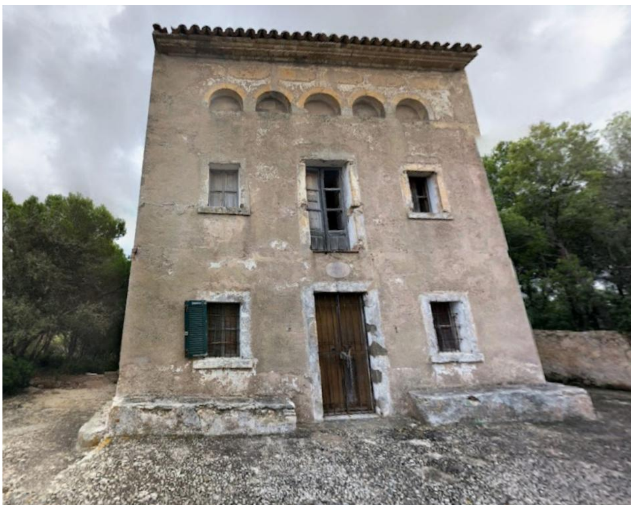
Figura 1. Estat actual de l'edificació de Bellavista, a Felanitx. Font: Street view, Google Maps 2018.
