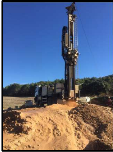
Figura 8: foto de una máquina perforando (Fuente: fotos Google)
