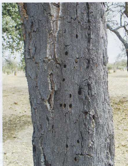
Fig. 18.- Tronco de alcornoque con numerosos taladros producidos por Cerambyx (Fotografía de P. E. Rosado).
