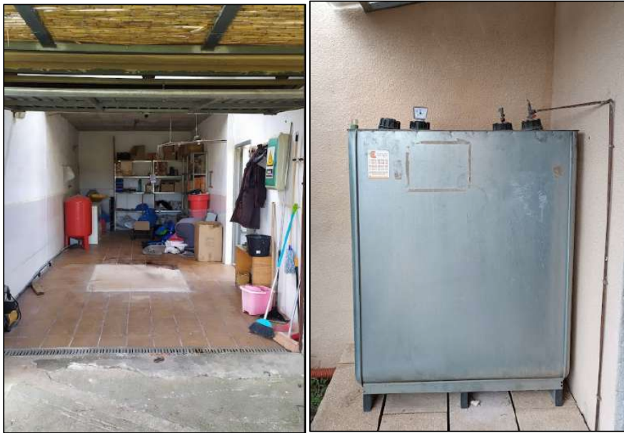
Imagen 8. Almacén y depósito de gasoil existente.
