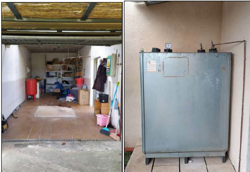
Imagen 8. Almacén y depósito de gasoil existente.
