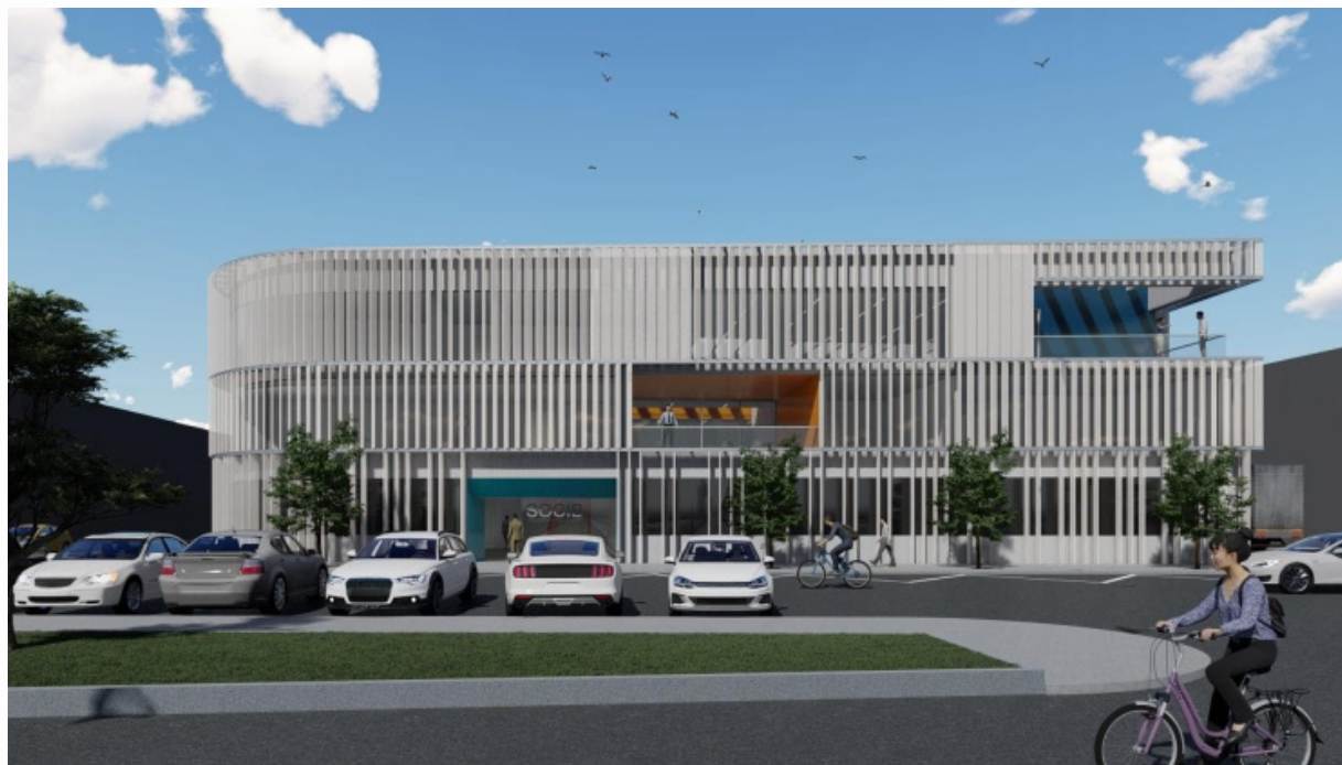
Construcció de la nova seu de l'ICTS SOCIB ( OE 1.1)
