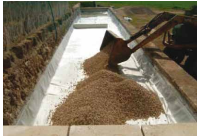
Aportación de grava cerámica reciclada (capa de 35cm). Laying of natural gravel (35 cm).
