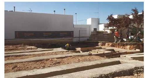
Cimentación de cal en masa Lime Foundation
