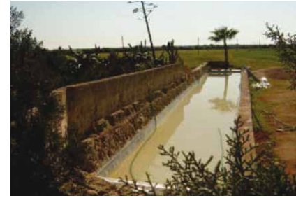
Prueba de impermeabilización. Waterproofing test.
