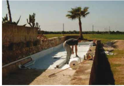
Colocación de la tela impermeable y geotéxtil. Placement of waterproof layer and geotextile.
