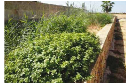
Instalación funcionando. Running installation.
