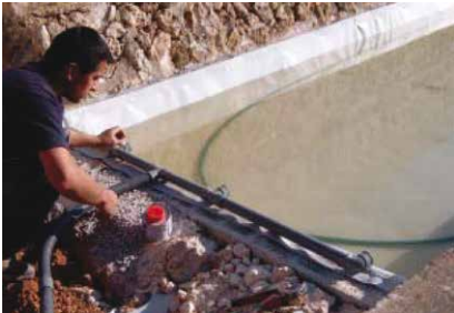
Instalación de fontanería. Plumbing installation.
