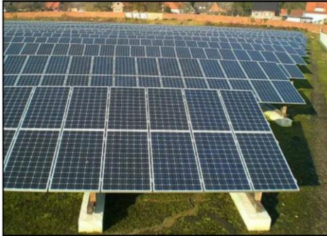
Ilustración 7. Ejemplo de estructura con bases de hormigón o riostras prefabricadas
