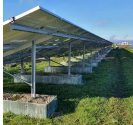
Ilustración 8. Ejemplo de estructura lastrada sobre gaviones
