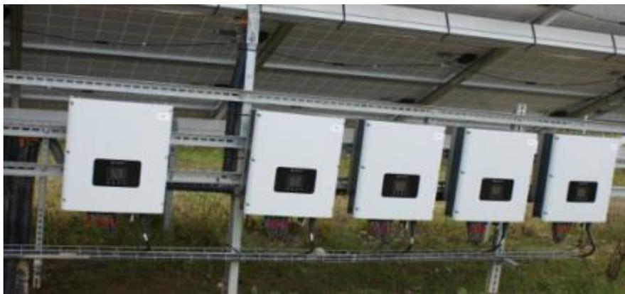
Ilustración 4.- Inversores situados bajo los paneles
