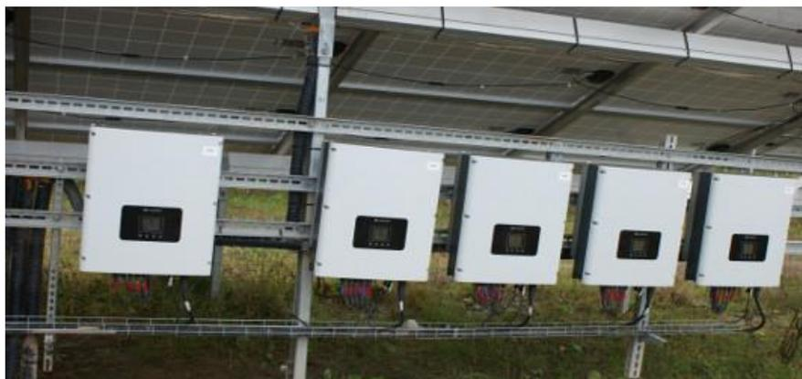
**Ilustración 6.- Inversores situados bajo los paneles**
