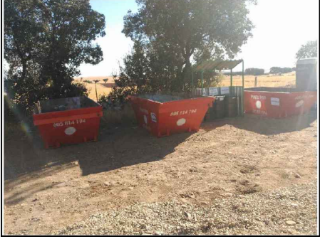
CONTENEDORES DE OBRA
