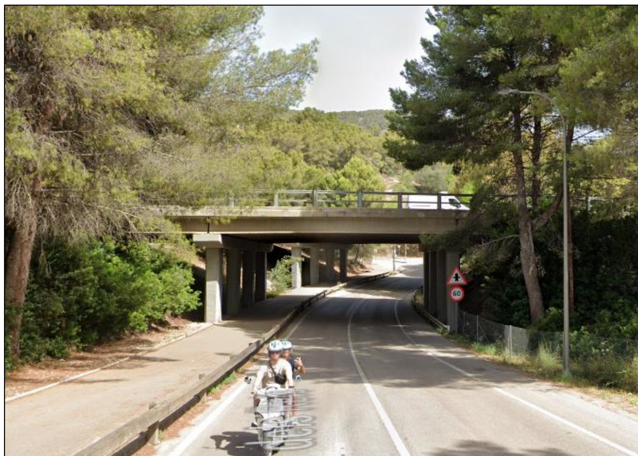
Imagen 4: Paso subterráneo de la autopista Ma-1.
