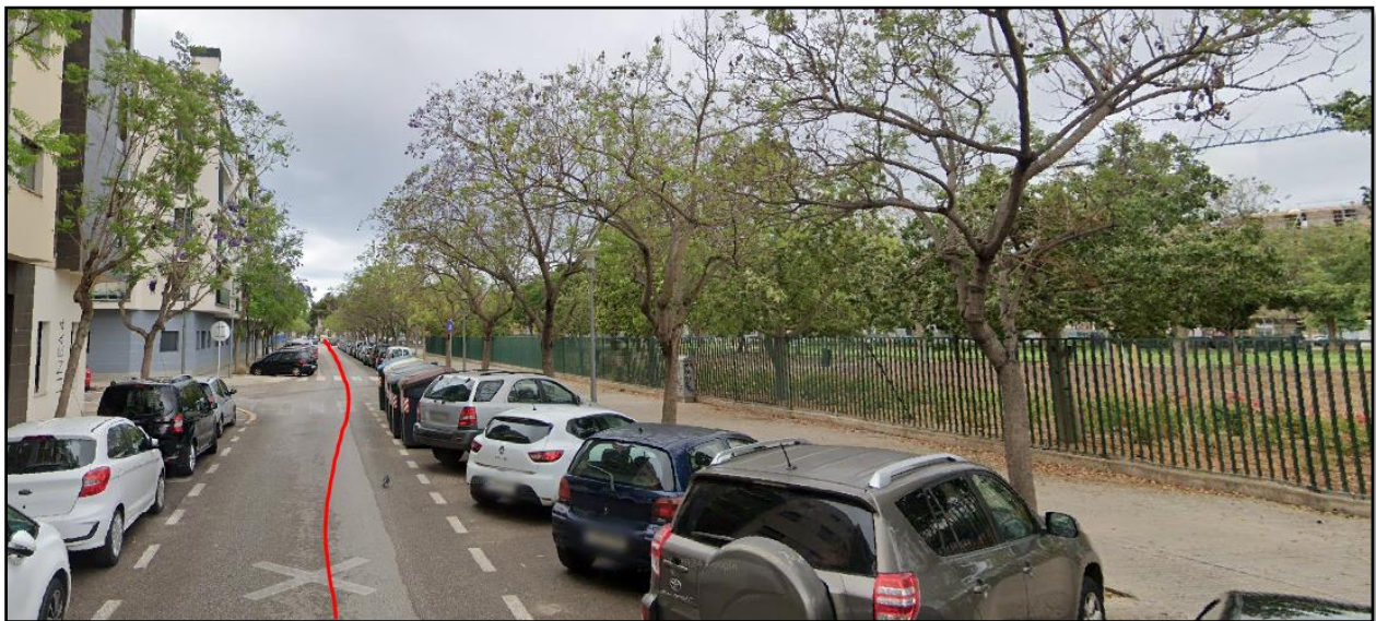
Imagen 10: Canalización por calle Angel Guimerà.
