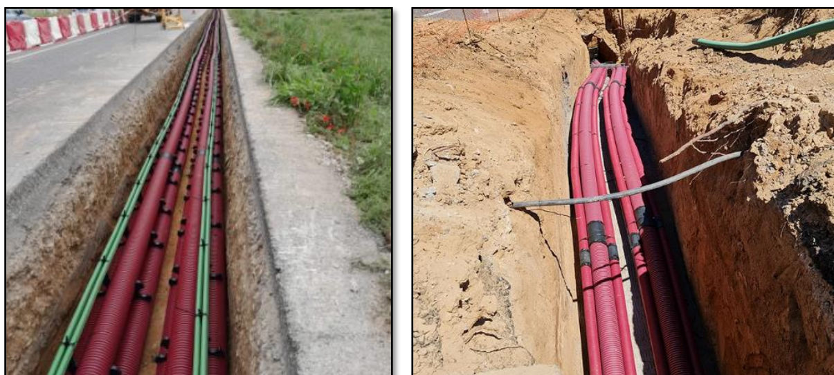
Imagen 4: Ejemplo de las zanjas propuestas.
