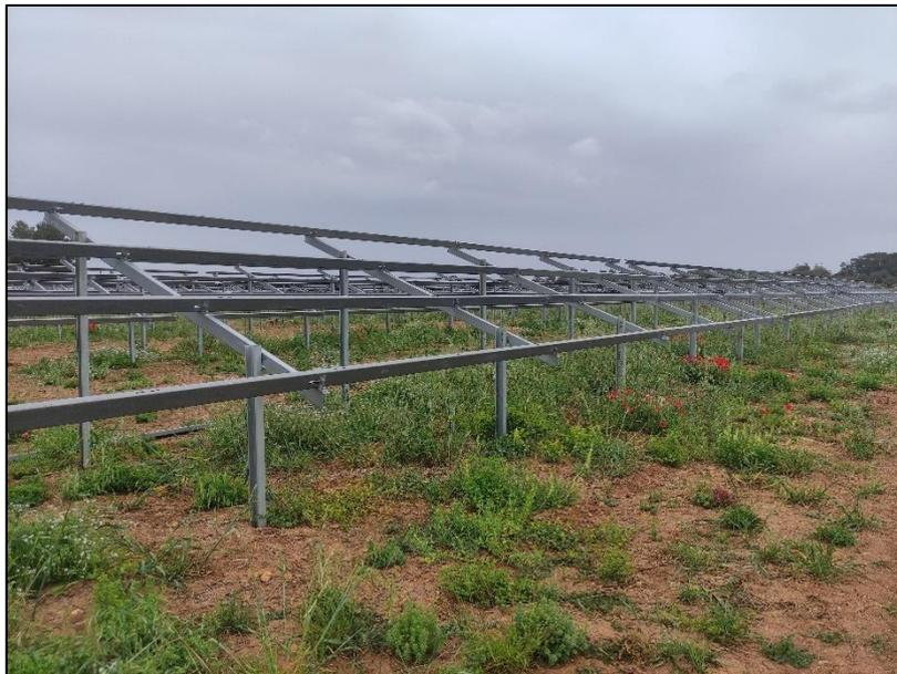
**FIGURA 6 EJEMPLO DE ESTRUCTURA DE SOPORTE HINCADA**
