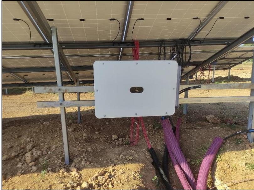
**FIGURA 9 INVERSOR DE CORRIENTE**
