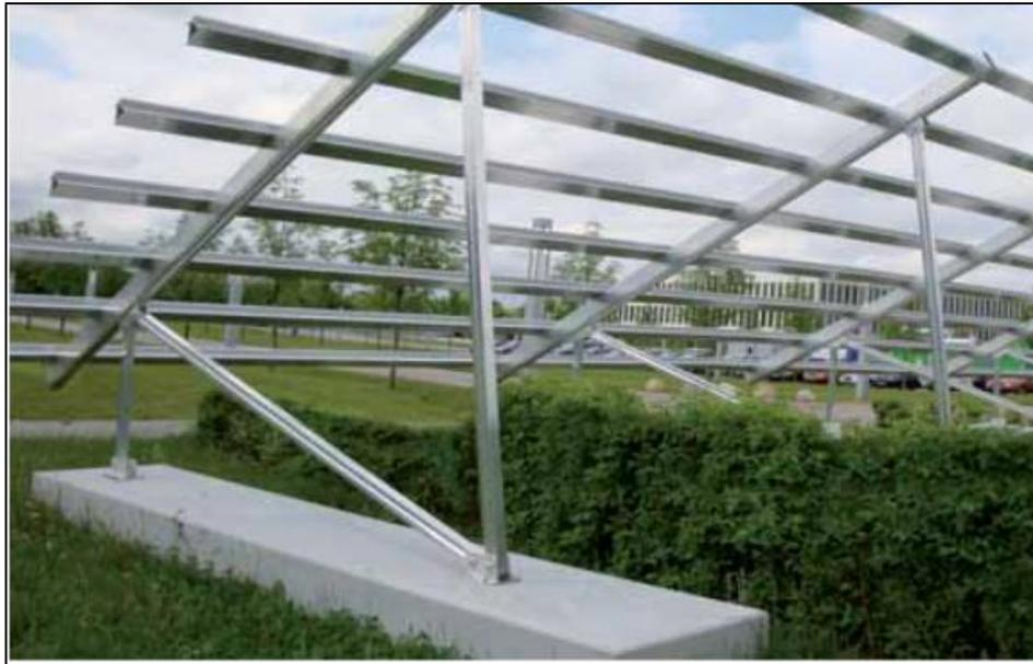
**FIGURA 7 ESTRUCTURA APOYADA SOBRE BASES HORMIGONADAS**
