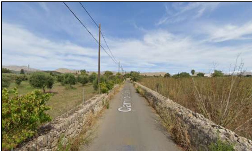
ILUSTRACIÓN 23 ACCESO SECUNDARIO CARRER DE CAN BOU ROS
