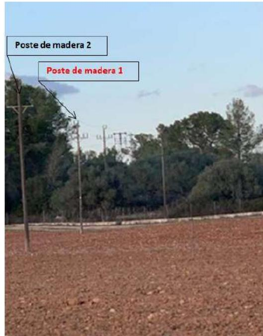
Imagen 8 Poste de madera 1 a cambiar por apoyo metálico C2000-14
