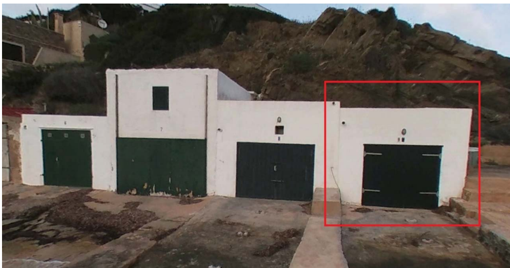
FOTOGRAFIA DEL CONJUNTO DE BARRACAS
