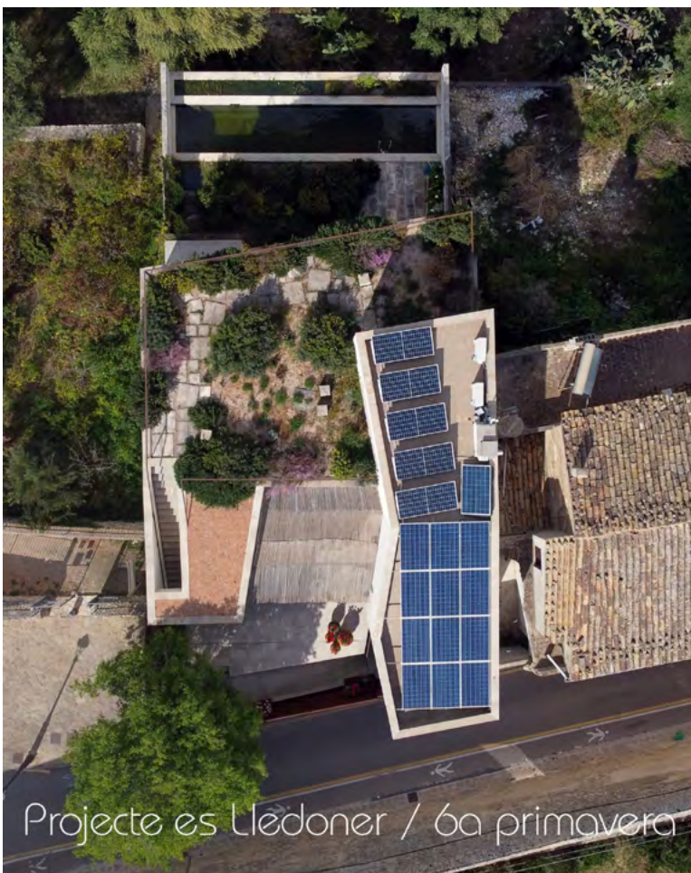
Figura 26. Coberta d'habitatge familiar entre mitgeres que combina sostre verd i producció d'energia solar. Projecte Es Lledoner, Inca. Arquitecte Jaume Lluís Salas. Font: MARES Arquitectura, Paisatge i Territori. https://www.m-ar.es/
