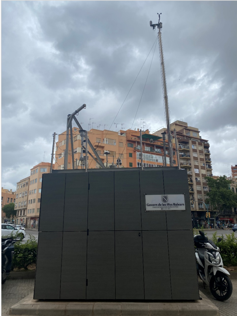
Imagen 4. Vista frontal de la estación de Foners.
