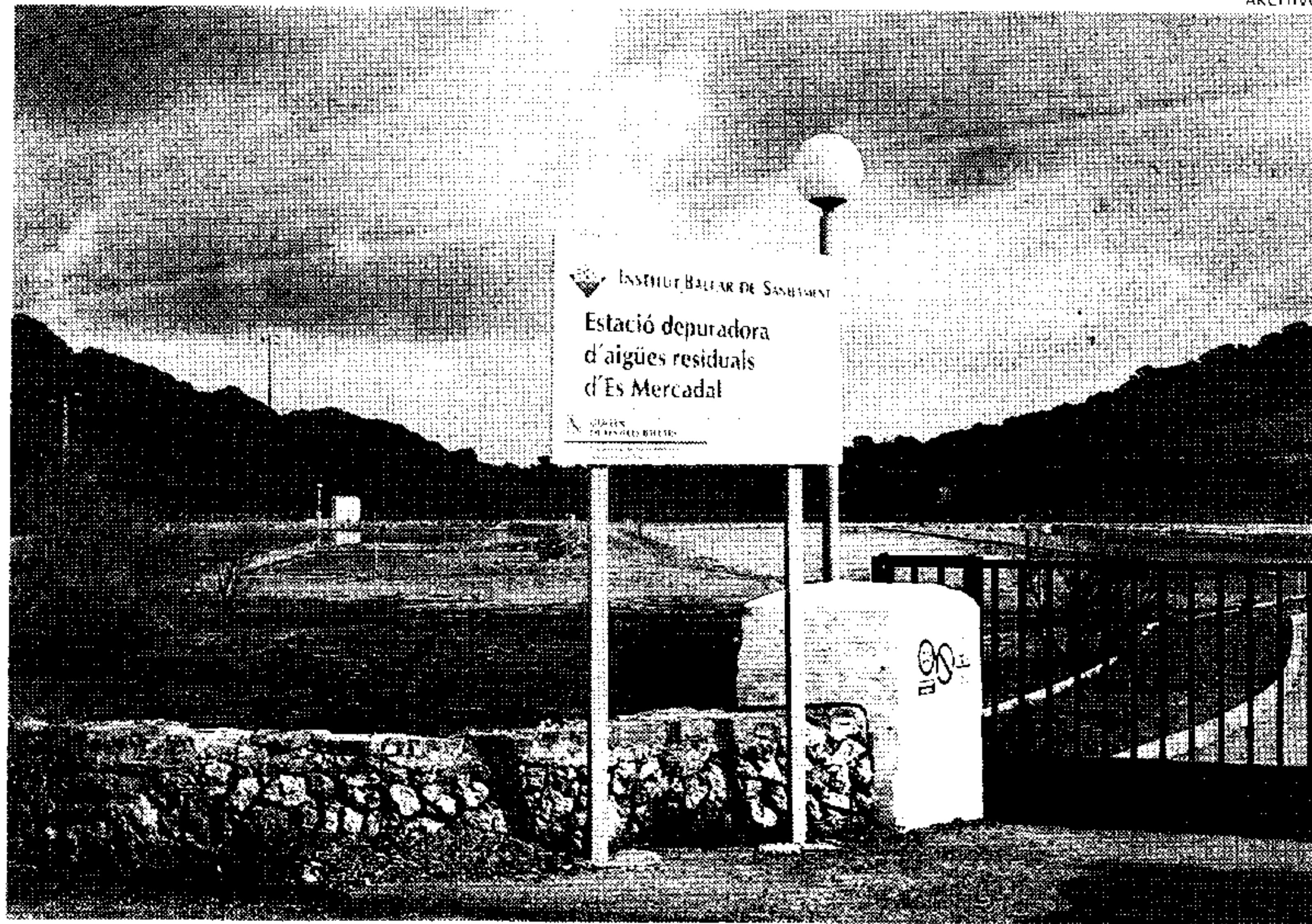
DEPURADORAS. El Plan contempla diversas mejoras en las instalaciones
