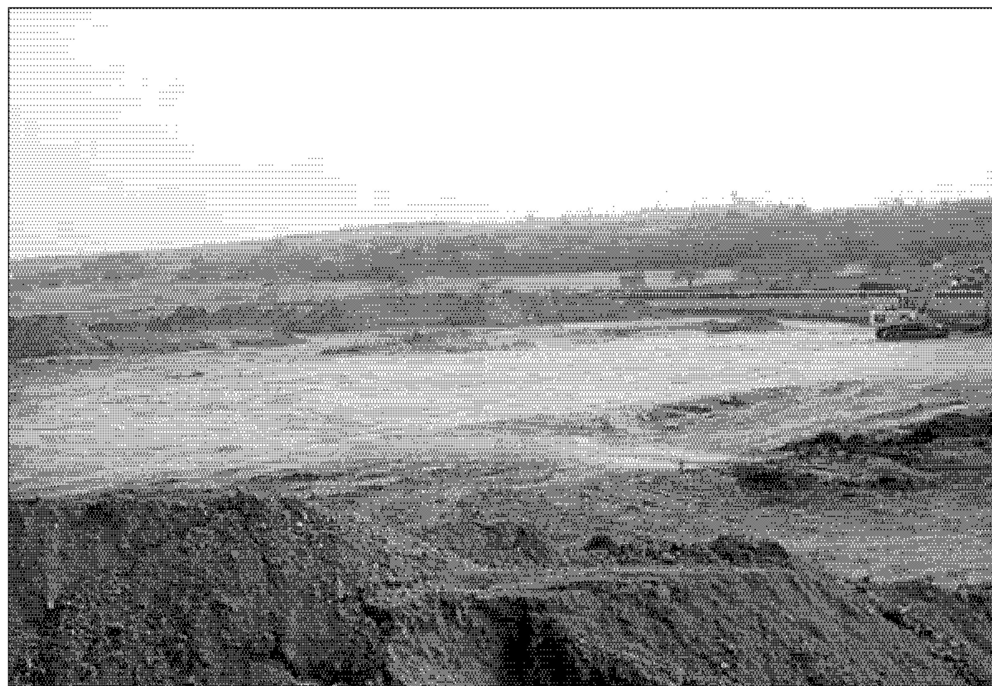
La construcción de la balsa avanza a un buen ritmo. FOTO: BIEL BERGAS.
