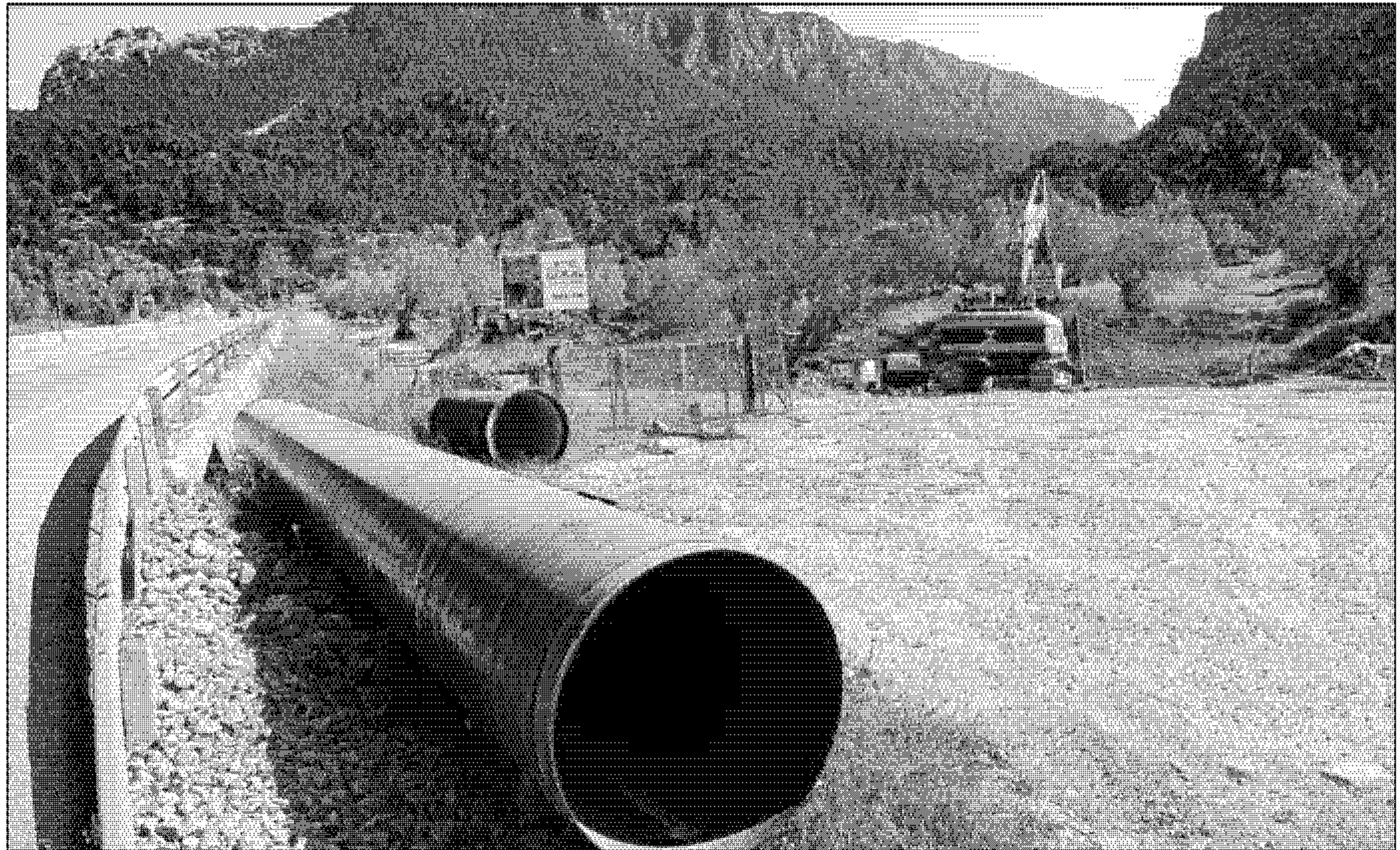
Imagen de las obras que permitirán inyectar agua de sa Costera a la red.
