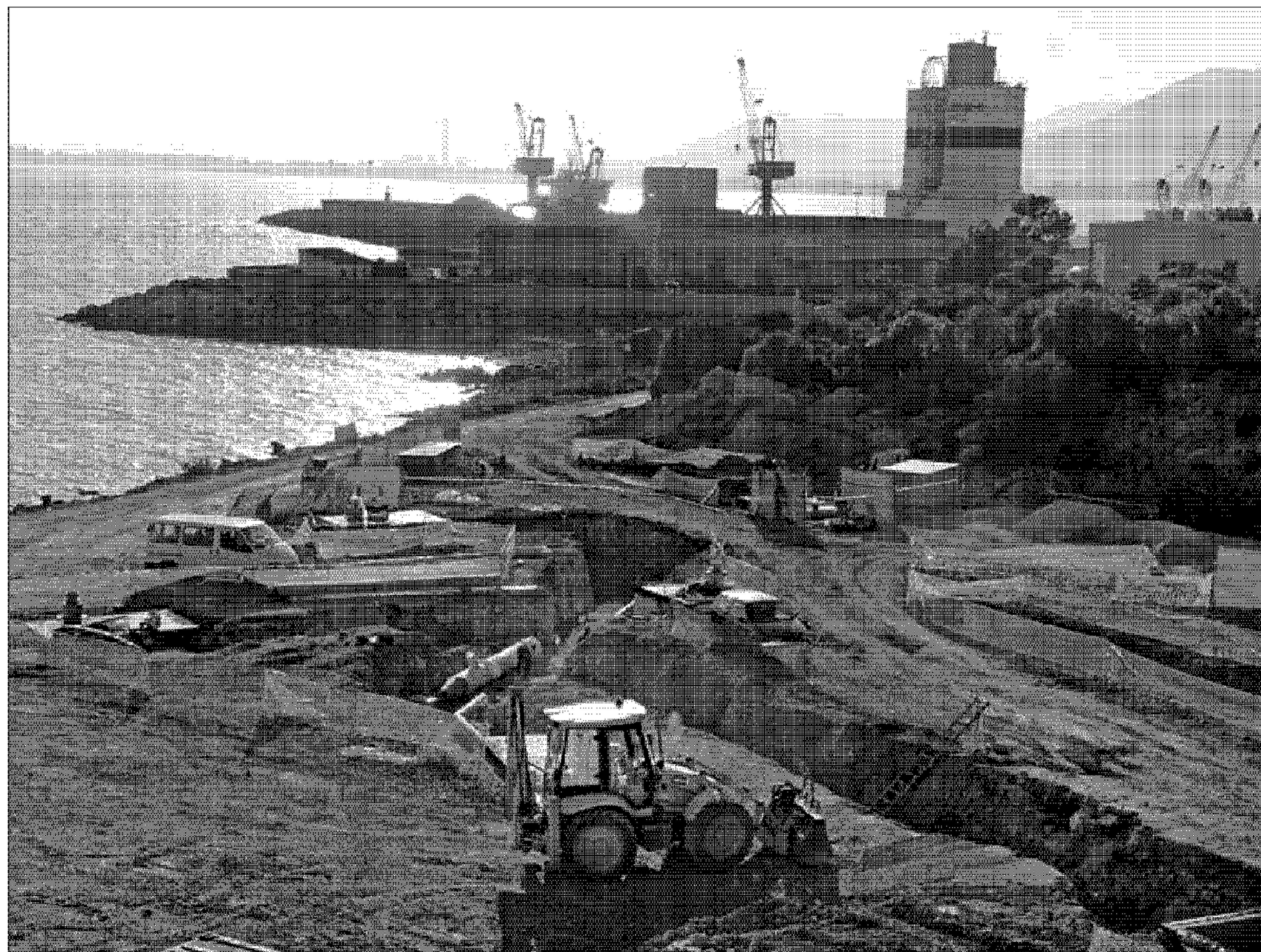
Los operarios ultimán las obras de canalización cerca de la nueva desaladora. FOTO: GUILLEM BOSCH.
