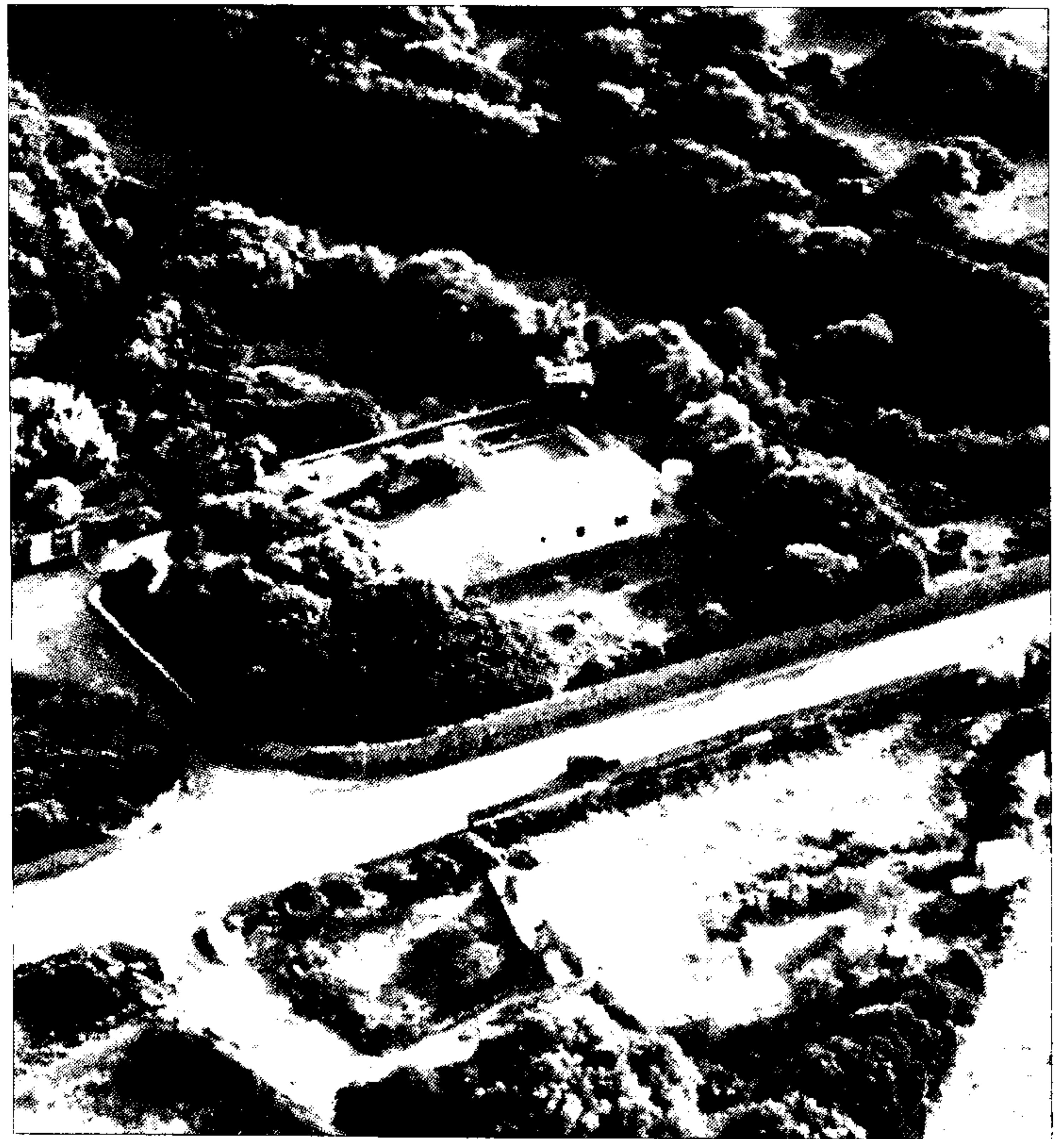
Imagen de la depuradora de Sant Climent. / GOB
