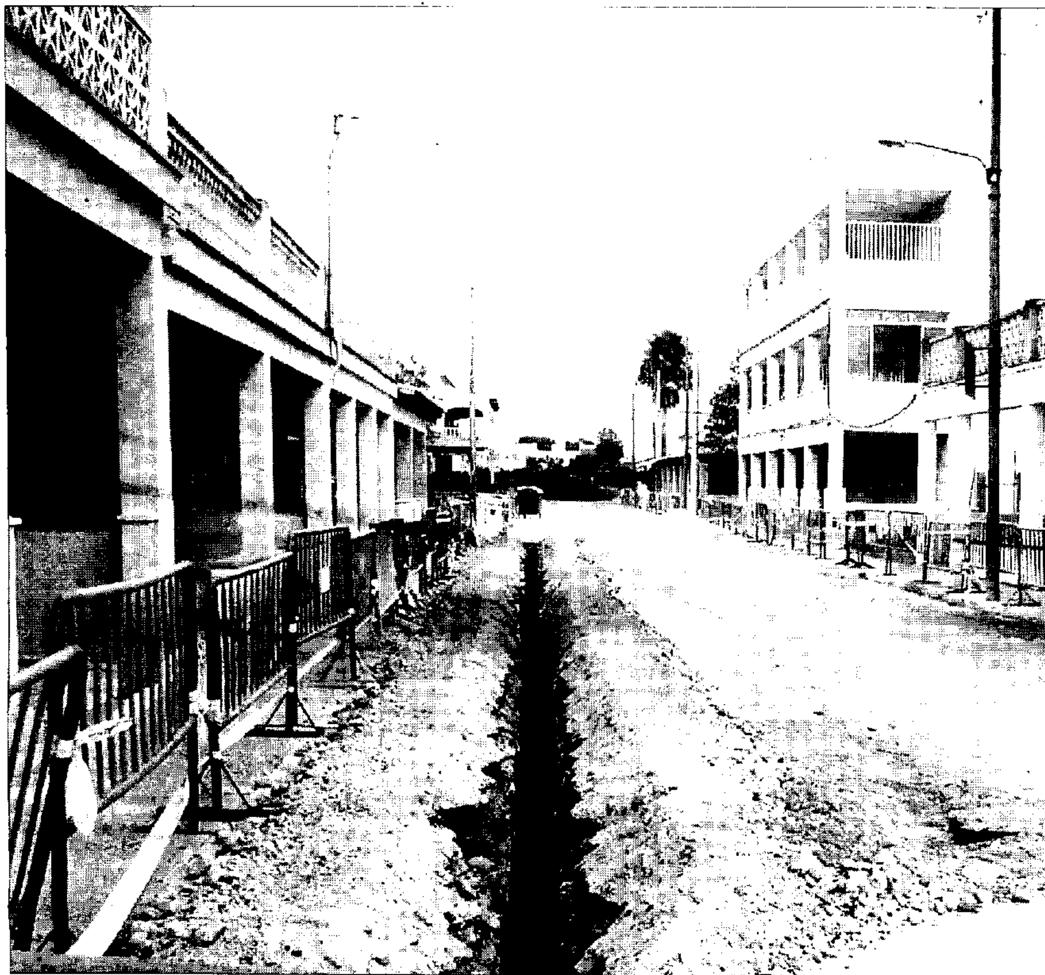
Las obras de la nueva red de abastecimiento de agua atravesando S'Estanyol.
