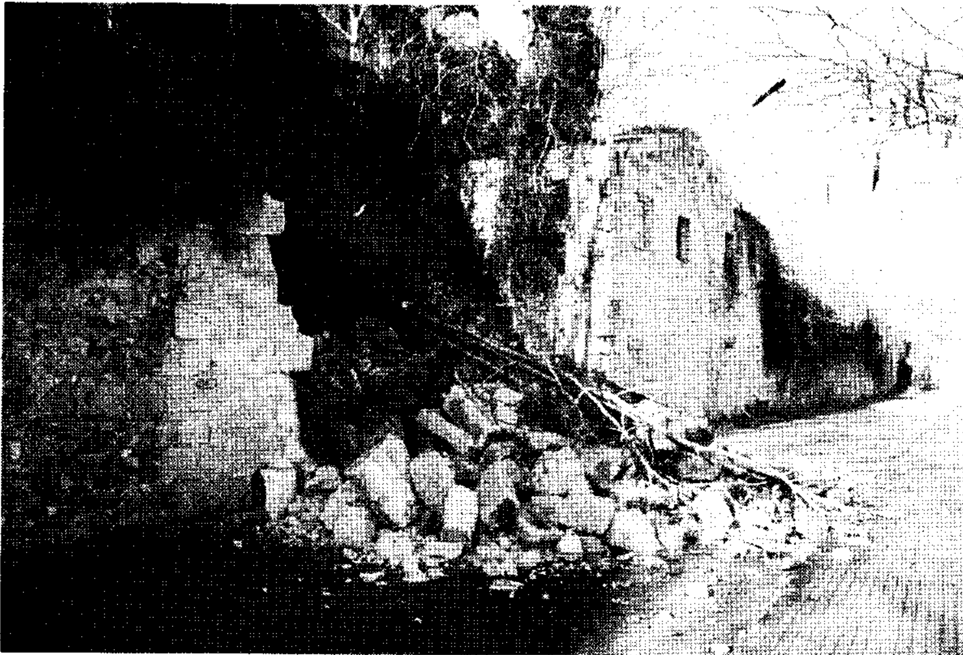
ACANTILADO. La Costa de ses Piques permanece cerrada a la espera de una intervención
