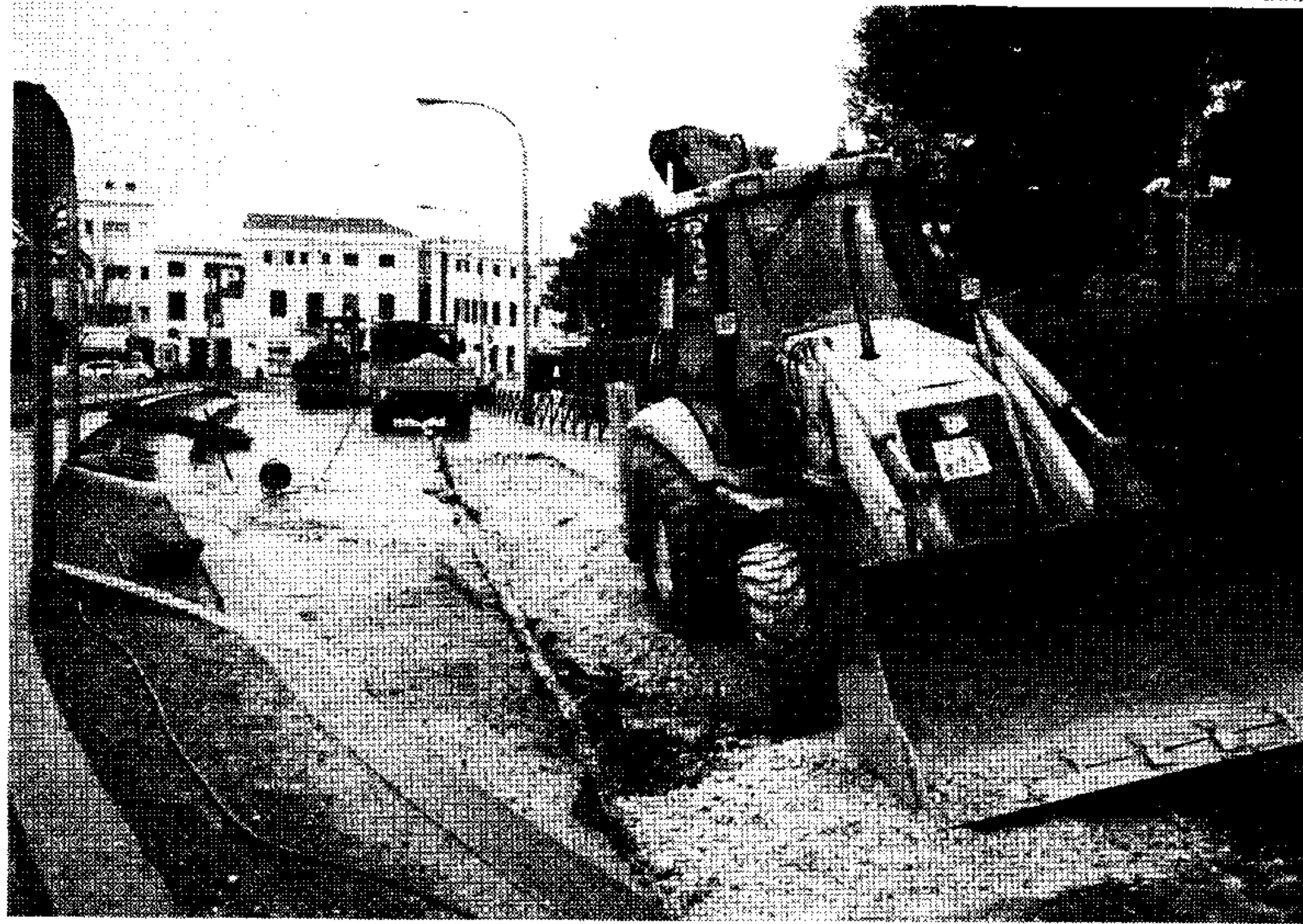
EXPLANADA. El socavón ha sido compactado y queda tan sólo asfaltar esta parte de la calle
