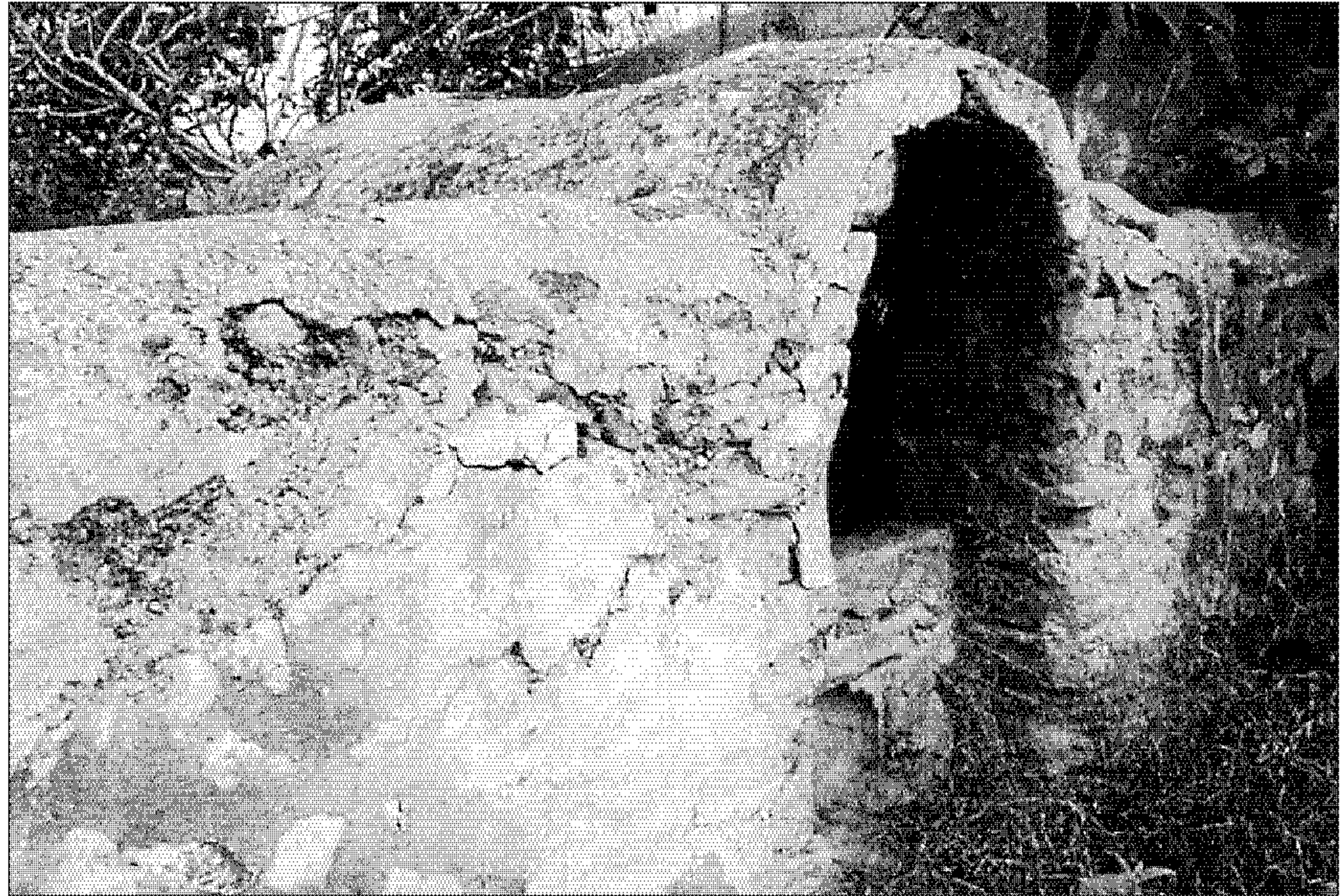
A los pozos antiguos se sumarán algunos de nueva apertura.
