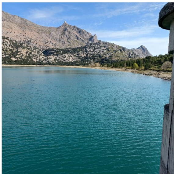
Fotografía 1: Embalse de Cúber desde el muro de presa
