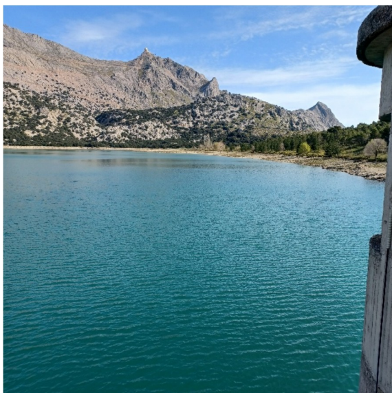
FOTOGRAFIA 1: Embassament de Cúber des del mur de presa
