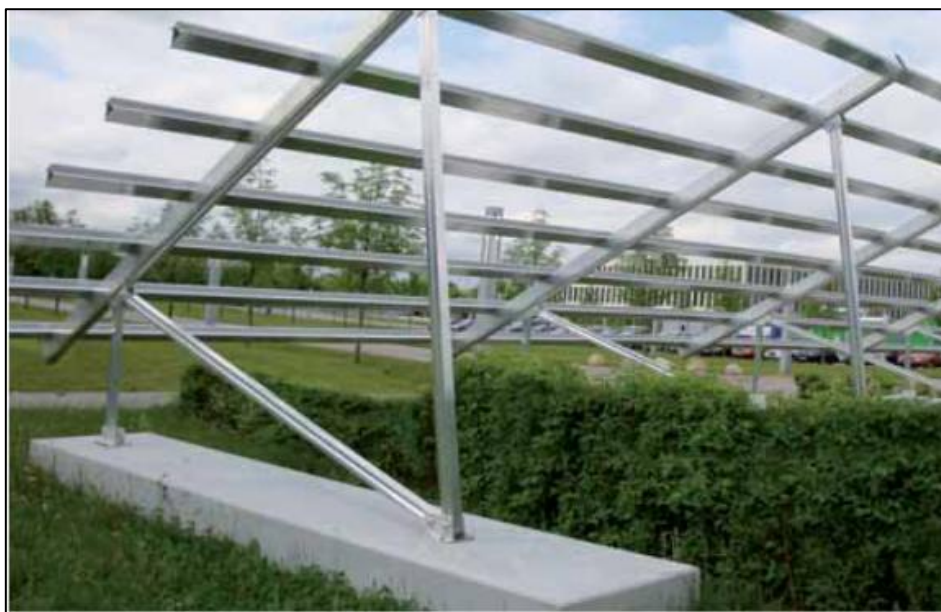
IL·LUSTRACIÓ 7 ESTRUCTURA SUPORTADA SOBRE BASES FORMIGONADES
