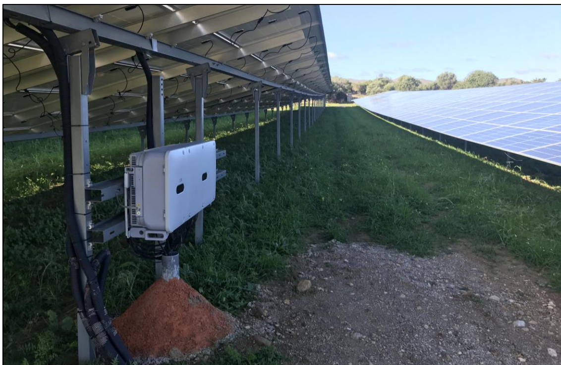
Il·lustració 9 Exemple d'instal·lació d'inversor sota estructura
