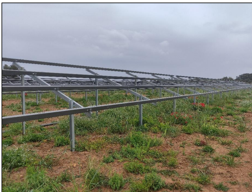
IL·LUSTRACIÓ 6 EXEMPLE D'ESTRUCTURA DE SUPORT CLAVADA
