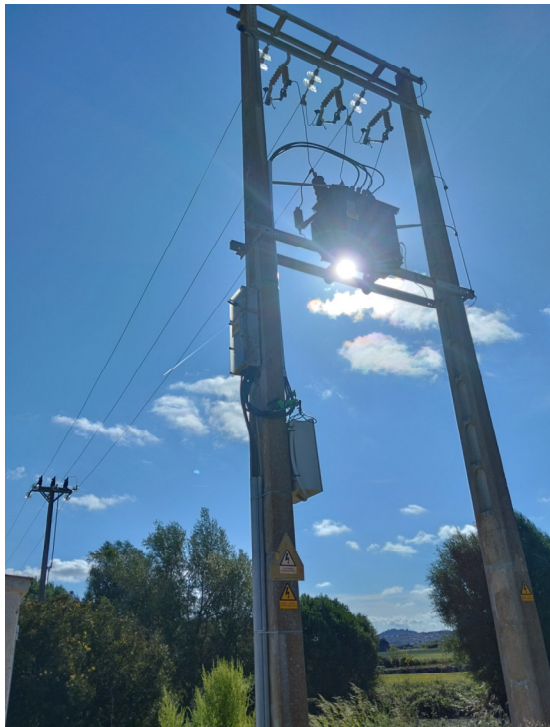
Figura 4. Imágenes del trafo aéreo sobre postes N.º 13474
