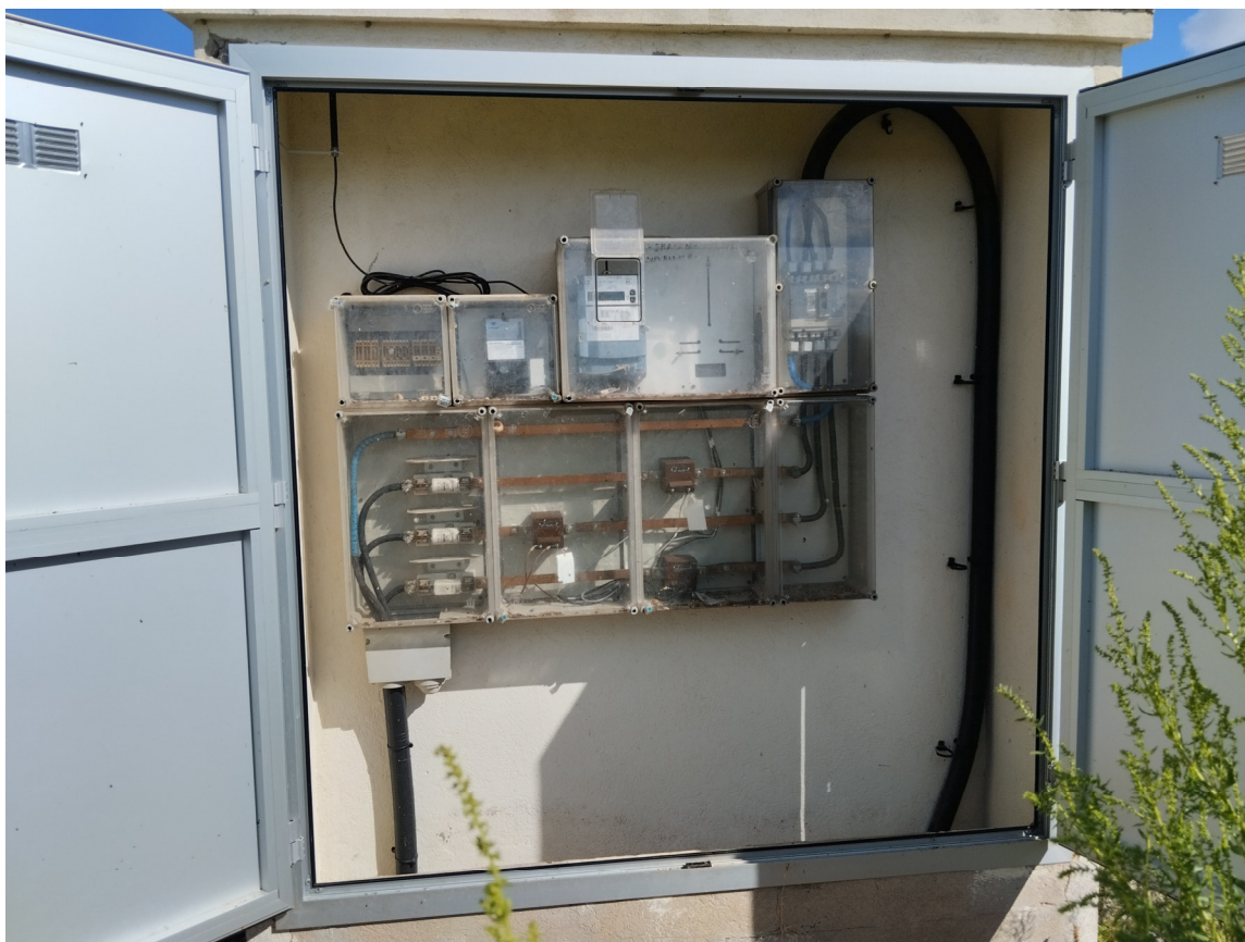
Figura 3. Imagen de la instalación de enlace y del armario del equipo de medida y seccionador
