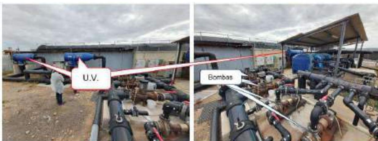
Imagen 10. Bombas de impulsión y equipos de filtración U.V. para destete 2
