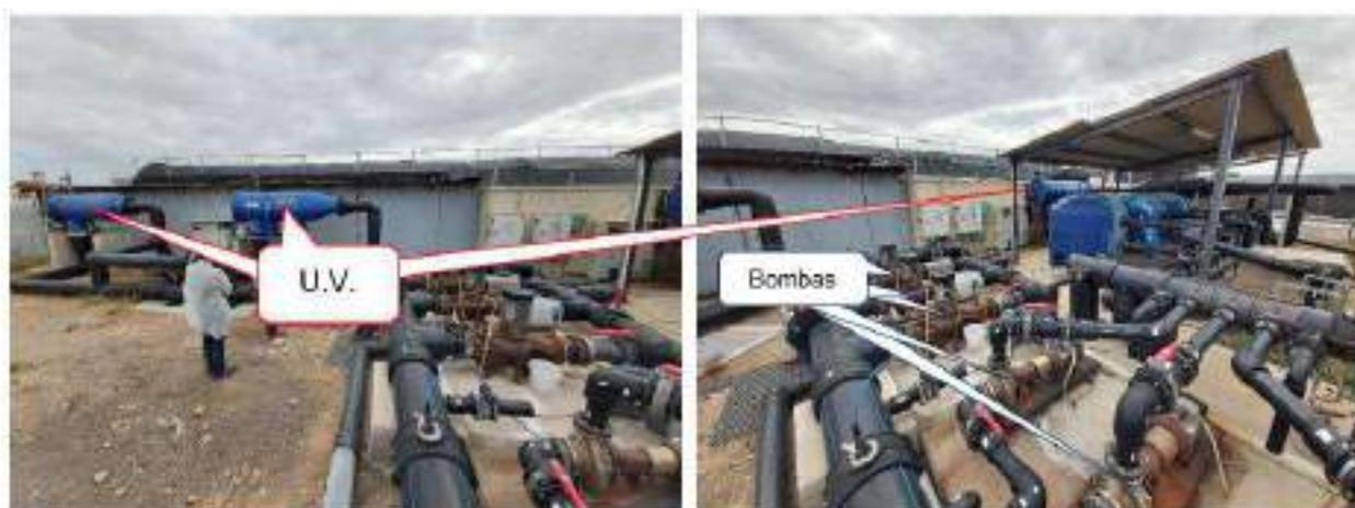
Foto 11. Bombas de impulsión y equipos de filtración U.V. para destete 2
