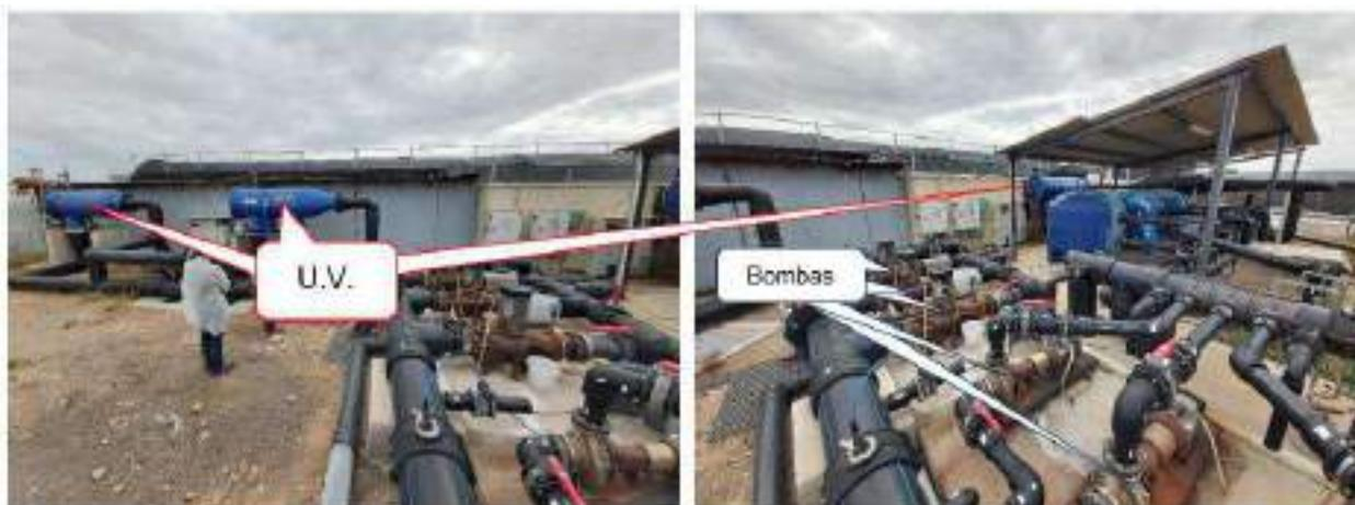
Foto 5. Bombas de impulsión y equipos de filtración U.V. para destete 2
