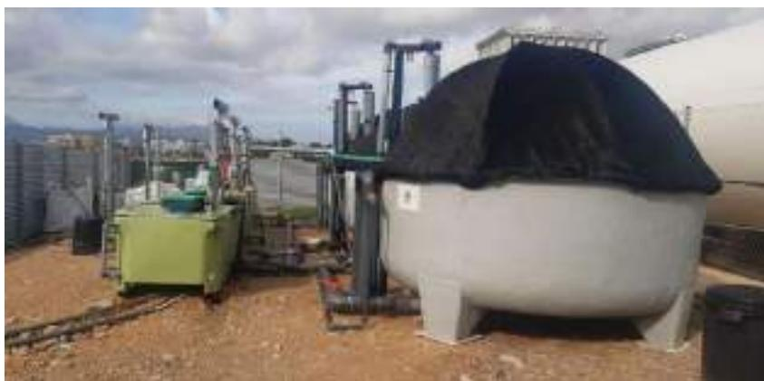
Foto 10. Depósitos prefabricados de cuarentena
