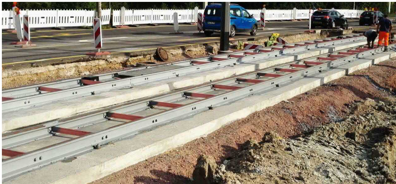
Figura 18: Vista de carril amb la pintura de protecció aplicada.
