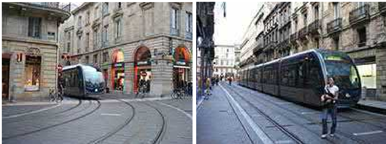
Tramvia de Bordeaux. Trams sense catenària, transcorrent pel casc històric, alimentats per un tercer carril subterrani mitjançant tecnologia APS (Alimentation par le Sol) de Alstom.
