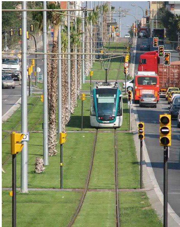
Plataforma reservada del tramvia de Barcelona.
