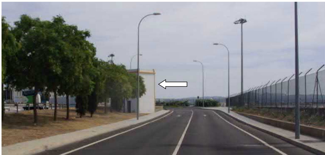
Situació del molí afectat.
