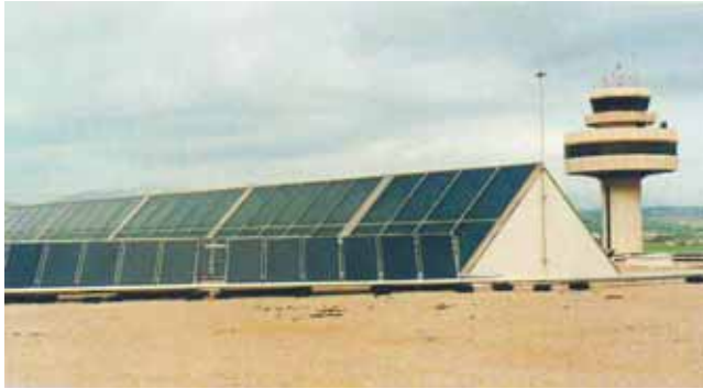
Instal·lació solar tèrmica.
