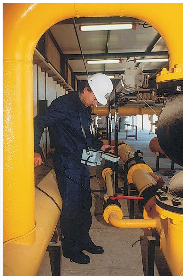
Operacions de manteniment preventiu.
