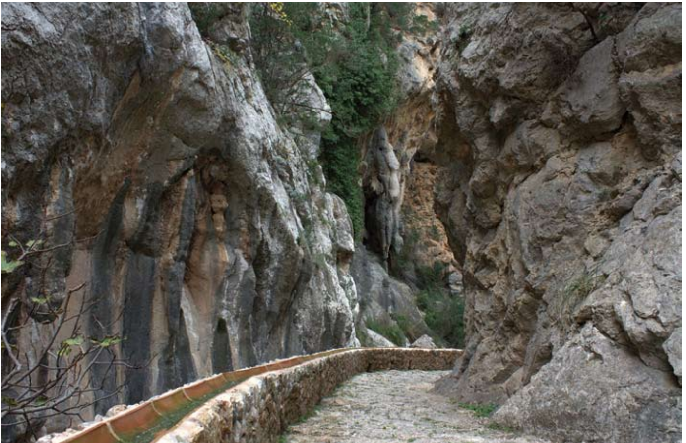
Wasserrinne an der Seite des gepflasterten Weges (Foto: Esperança Perelló).
