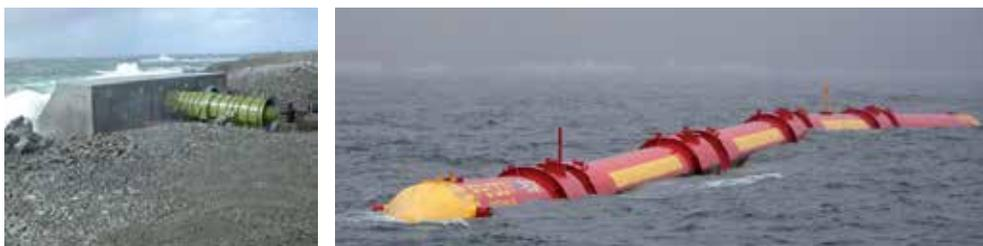
Entre los dispositivos fijos en la costa, mencionaremos el sistema LIMPET que, aunque todavía no esté plenamente desarrollado, constituye la tecnología más probada y contrastada en virtud de su funcionamiento ininterrumpido en una planta de 500 kW de potencia instalada, por un periodo superior a dos años. Se trata de un sistema de columna de agua oscilante que puede instalarse dentro de los rompeolas de los puertos.
