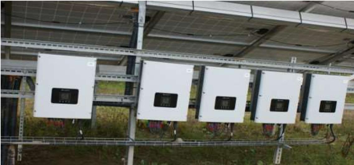
Ilustración 7.- Inversores situados bajo los paneles.
