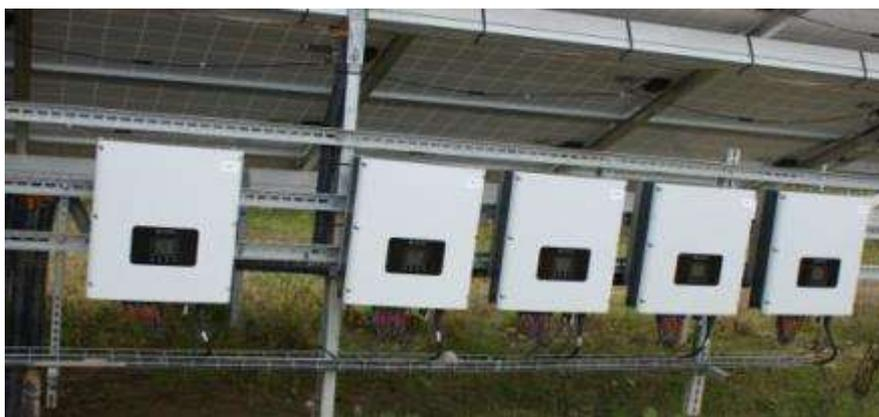
**Ilustración 39.- Inversores situados bajo los paneles.**
