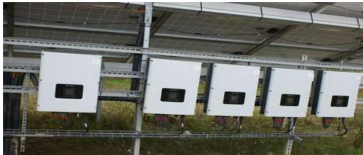
Ilustración 18.- Ejemplo real de instalación de paneles solares e inversores bajo los paneles.0
