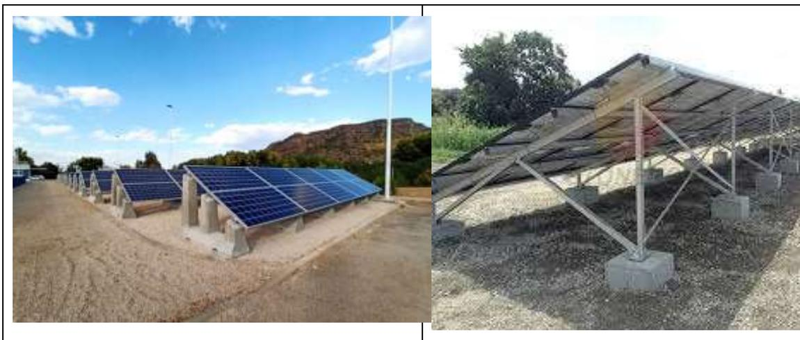
Ilustración 40.- Ejemplos de uso de soportes de hormigón, alternativa rechazada.
