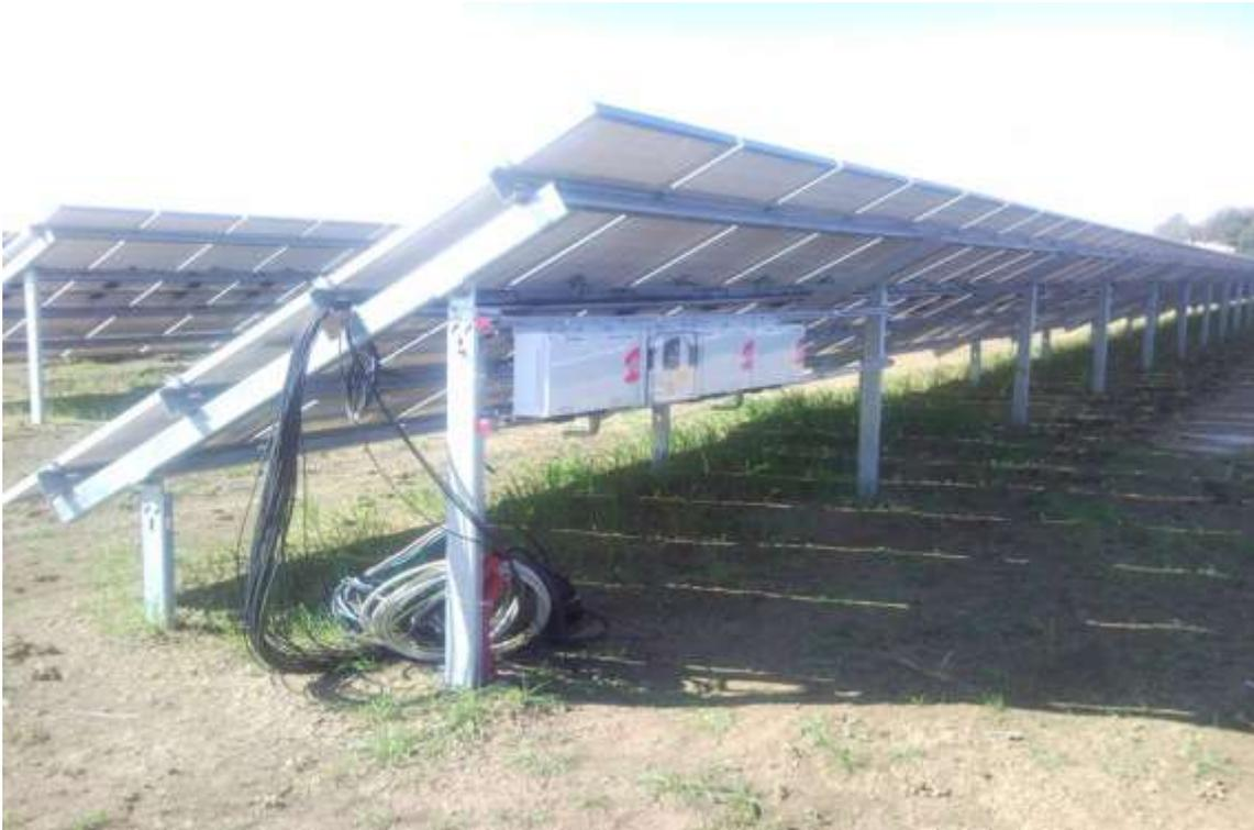
**Ilustración 9.- Ejemplo de sistema de soporte.**
