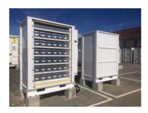
Los armarios "Blue LMP 400" se pueden ensamblar para aumentar la capacidad de almacenamiento total y alcanzar la escala de MWh.
