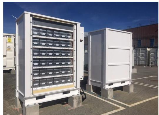
Los armarios “Blue LMP 400” se pueden ensamblar para aumentar la capacidad de almacenamiento total y alcanzar la escala de MWh.
