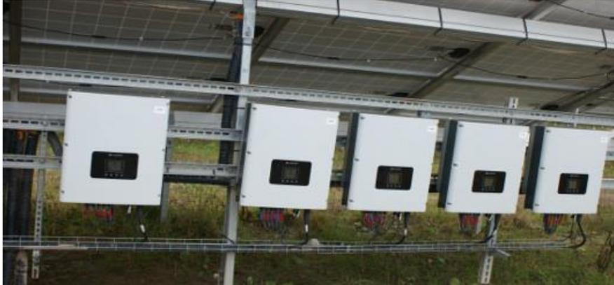
Ilustración 2.- Inversores situados bajo los paneles
