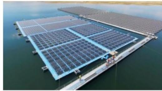
La instalación a proyectar está compuesta por un sistema de generación fotovoltaico formado por paneles fotovoltaicos de 340 W, instalados sobre una estructura flotante a base de HDPE inclinados  $15^\circ$  y orientados hacia el sur. Se espaciarán a lo largo de la plataforma para permitir el paso de los operarios de mantenimiento. Se ha escogido esta inclinación, por debajo de la óptima en la latitud del emplazamiento, para evitar excesivos esfuerzos provocados por el viento.
