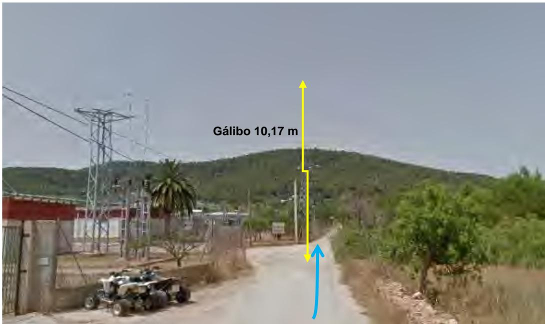
En aplicación del RD 614/2001 el vehículo con su carga no invade la zona de proximidad según se indica en la Ilustración 12.
