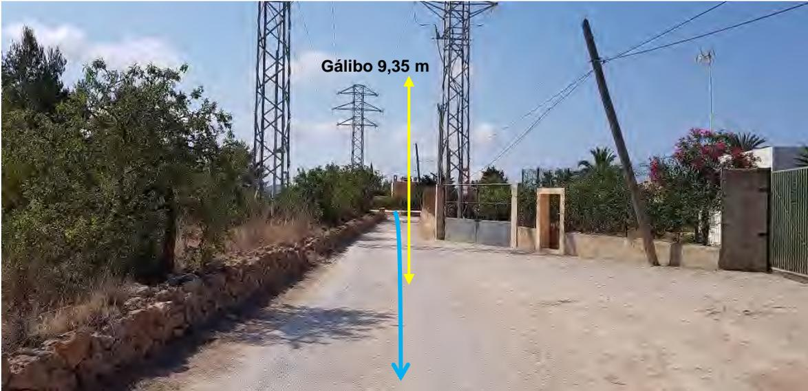
En aplicación del RD 614/2001 el vehículo con su carga no invade la zona de proximidad según se indica en la Ilustración 11.
