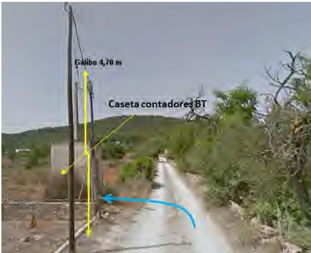
Ilustración 14.- Afección cruzamiento por gálibo vertical en PK 0+668
