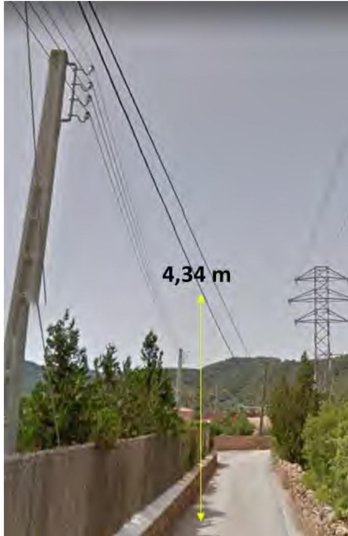
Ilustración 10-Afección a cruzamiento por gálibo vertical en PK 0+471
