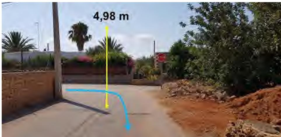
Ilustración 8.-Afección al tendido aéreo por gálibo vertical en PK 0+094
