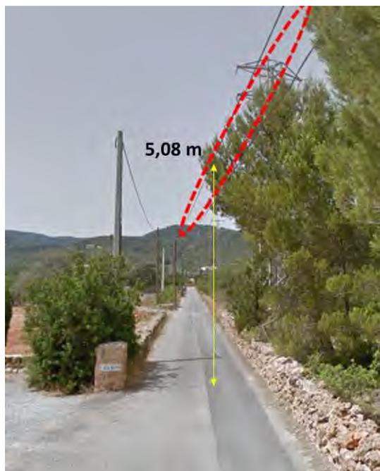
Ilustración 9.-Afección a cruzamiento por gálibo vertical en PK 0+334
