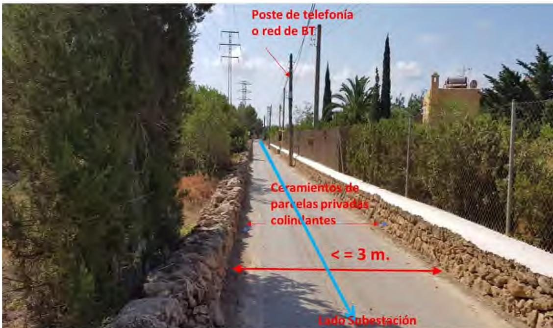
Ilustración 5.- Sección tipo del vial de acceso actual
