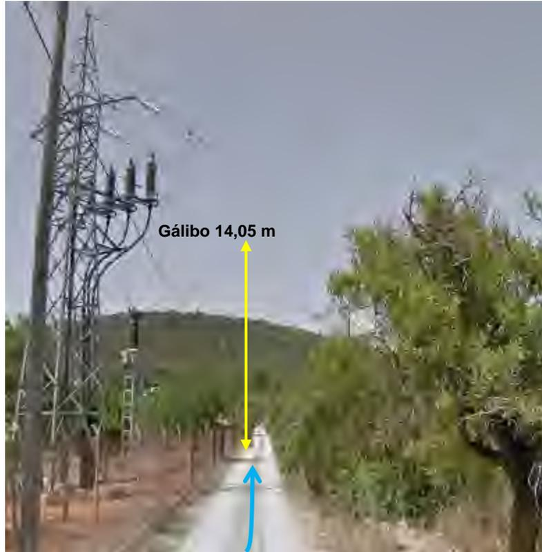
En aplicación del RD 614/2001 el vehículo con su carga no invade la zona de proximidad según se indica en la Ilustración 13.
