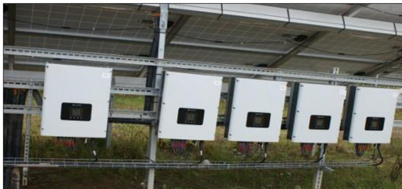
Ilustración 7.- Inversores situados bajo los paneles
