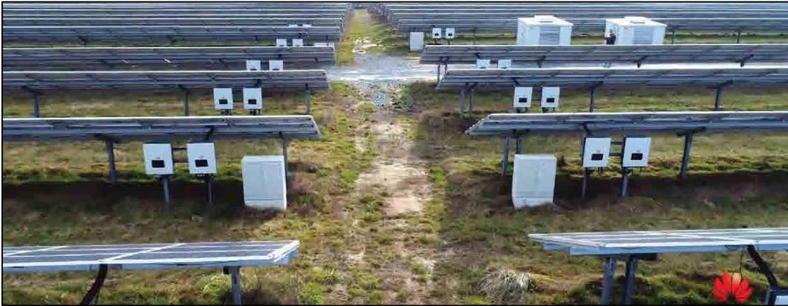
Ejemplo real de instalación de paneles solares e inversores Huawei sobre estructuras de soporte + Caja colectora AC
