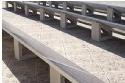
Figura 5. Ejemplo estructura soporte: Sistema inclinado mediante hormigón
