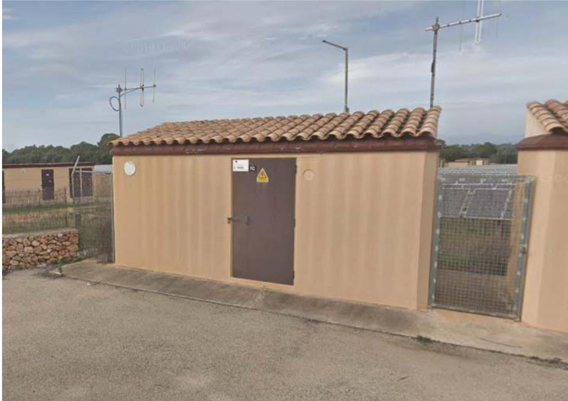
Ejemplo de edificio prefabricado con acabados adaptados
