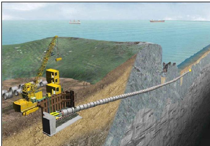
*Ejemplo de aterraje mediante perforación horizontal dirigida.*
