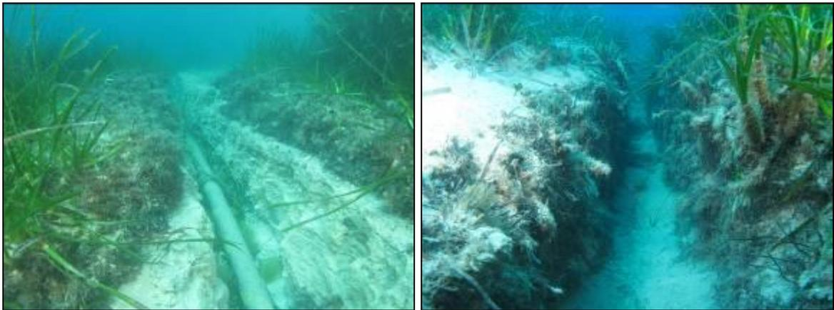
Imágenes de la zanja abierta mediante trenching específico sobre posidonia. A la izquierda se aprecia la zanja sobre sustrato duro y a la derecha sobre sustrato blando.
