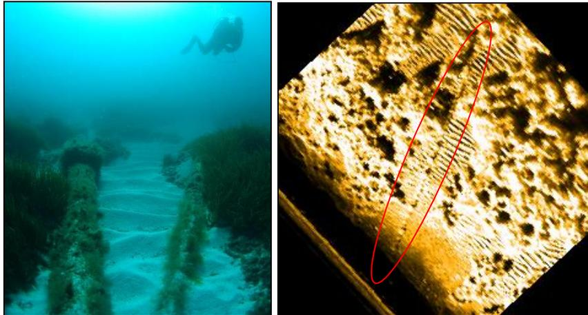
*Imágenes del emisario obtenidas mediante el registro de video (izquierda) y del sonar de barrido lateral (derecha).*
